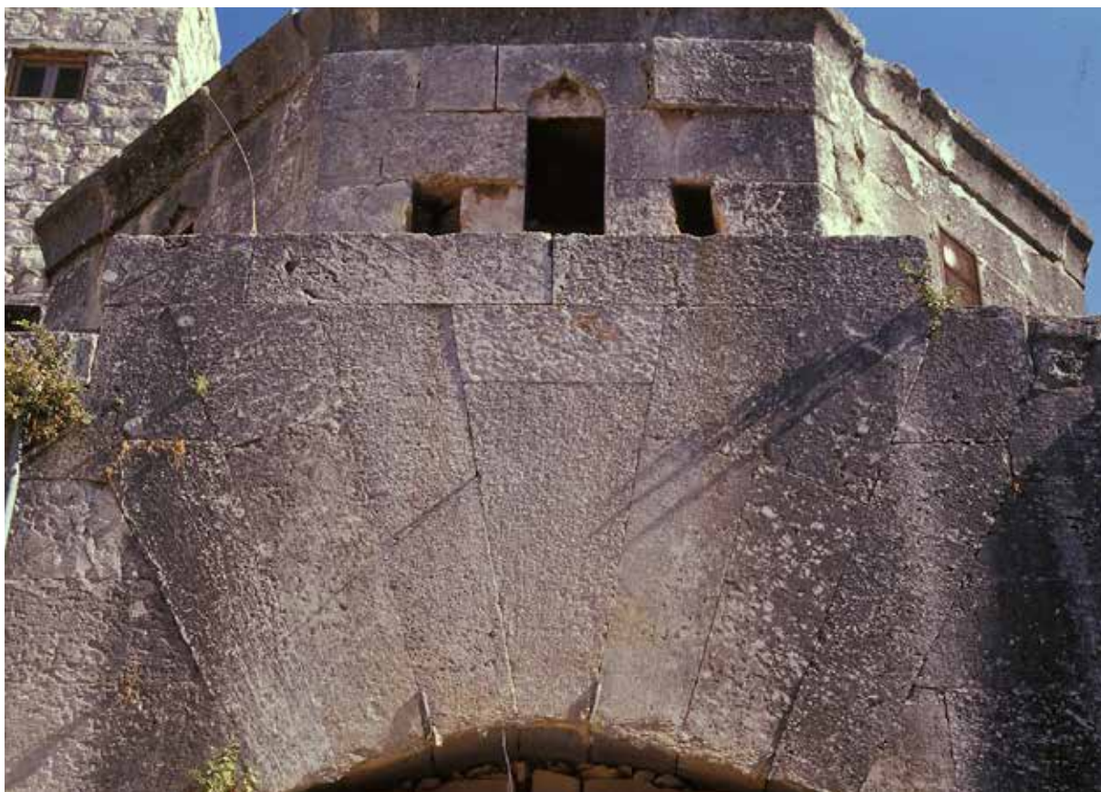
Fig.12 Madrasat Abu-l-Fawares. Façade de la salle d'enseignement. Photo MH.
