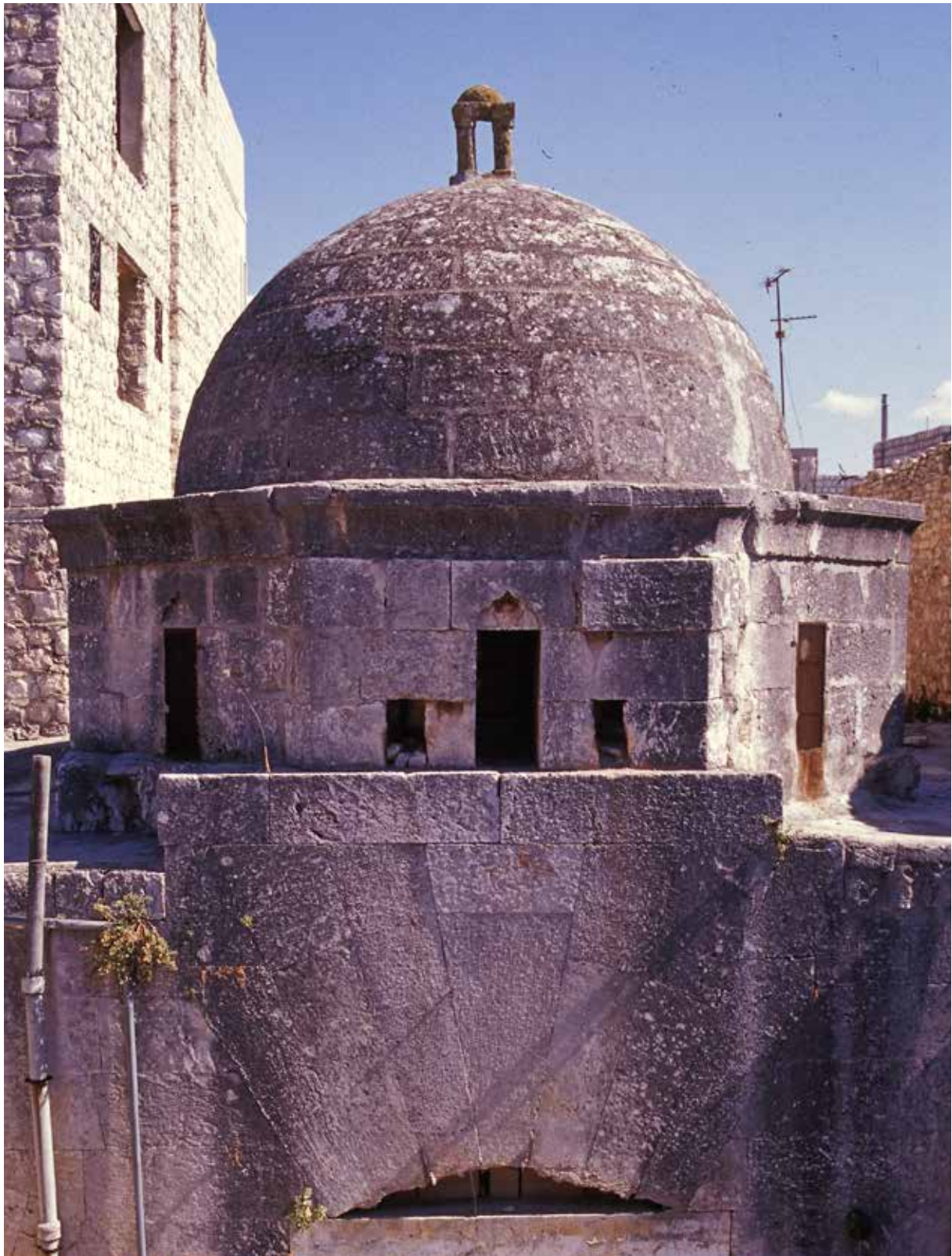
Fig.11 Madrasat Abu-l-Fawares. Façade et extrados de la coupole au-dessus de la salle d'enseignement. Noter la stéréotomie soignée. Les clavaux de voûte visibles sur l'extrados sont aussi visibles sur l'intrados. Photo MH.
