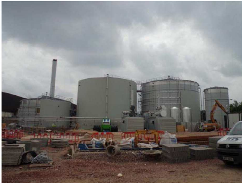
Cuve d'hydrolyse et digesteurs.
